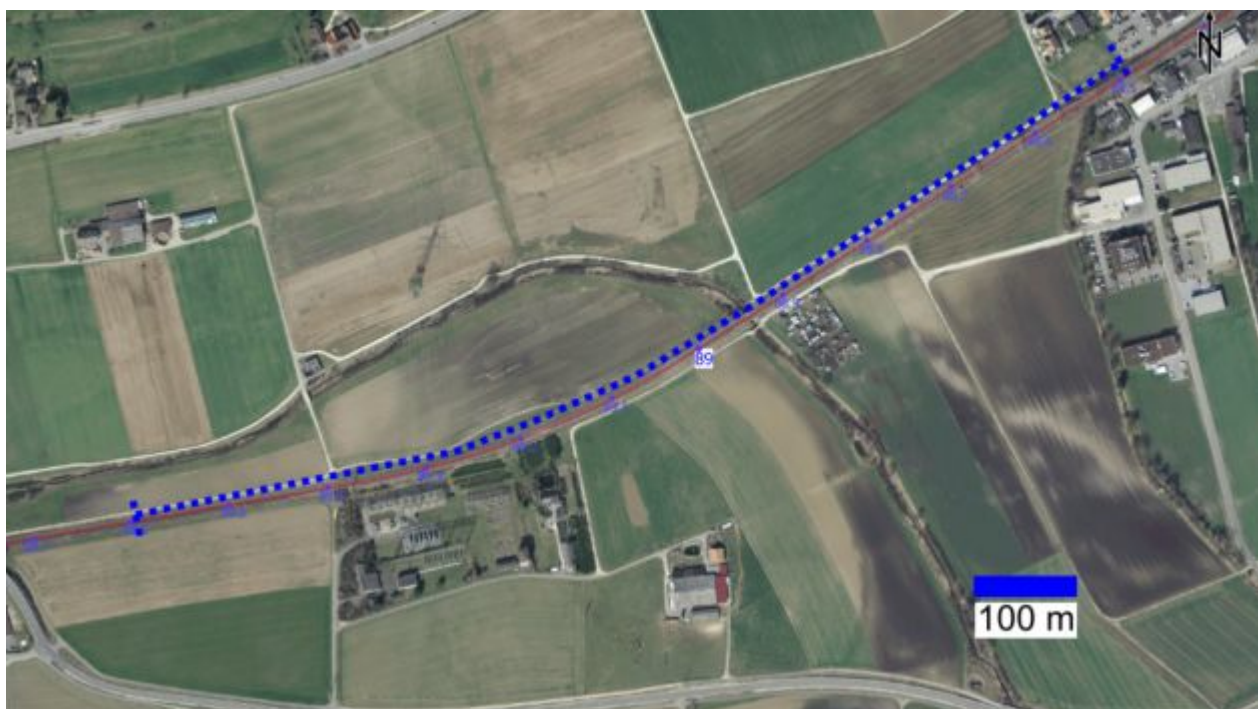
Abbildung 1. Orthofoto mit Lage der Teststrecke EKS. Die Schwellenbesohlung wurde beim südlichen Gleis eingebaut, das nördliche Gleis im bezeichneten Abschnitt wurde gleichzeitig mit der Teststrecke erneuert. In Richtung links folgt der Bahnhof Pieterlen, rechts der Bahnhof Lengnau (beide Bahnhöfe liegen ausserhalb des abgebildeten Ausschnitts). Reproduziert mit Bewilligung des Bundesamtes für Landestopographie 2004.
