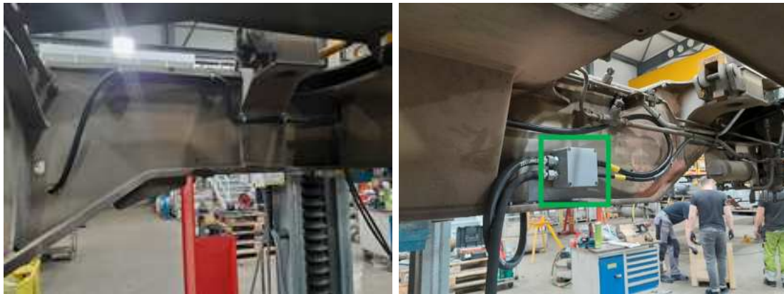
Abbildung 7.10: Anordnung der Kabel und des Klemmkastens am ersten Drehgestell nach Einbau [eigene Darstellung].
