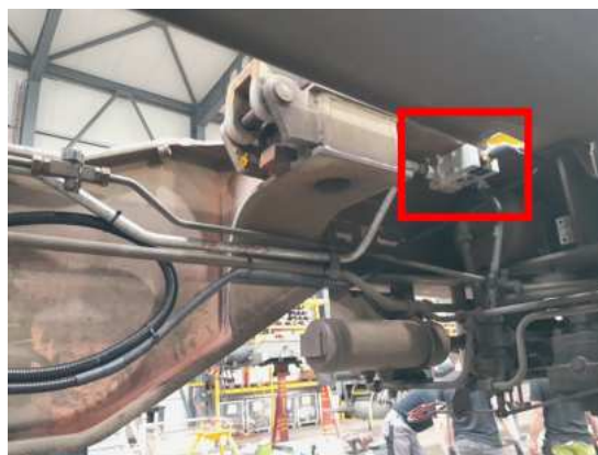
Abbildung 7.11: Anordnung des Gleitschutzventils am ersten Drehgestell nach Einbau [eigene Darstellung].
